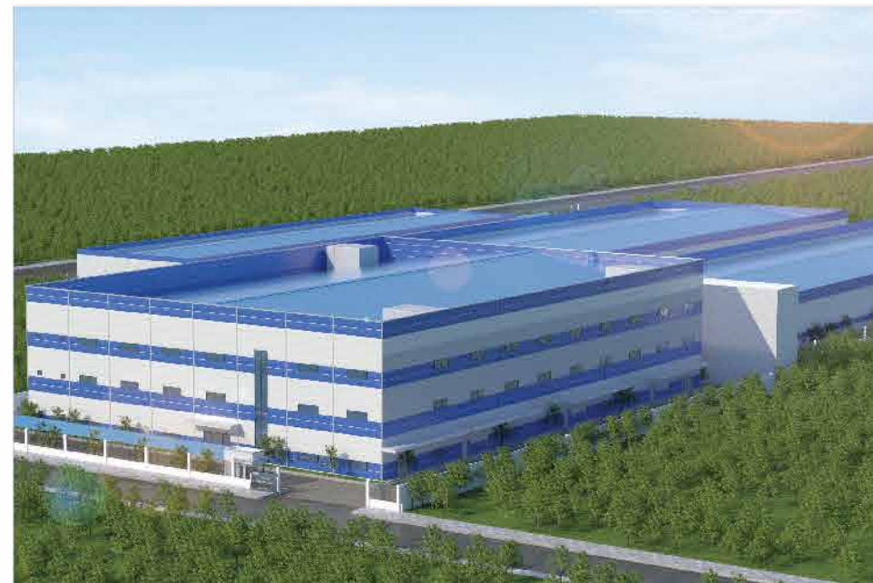
NHÀ MÁY YOUNGBO GIAI ĐOẠN 3 KCN Quế Võ, tỉnh Bắc Ninh
