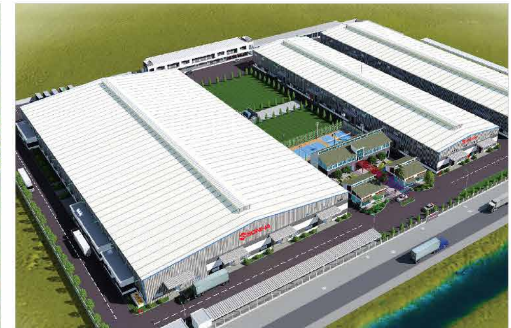
NHÀ MÁY SƠN HÀ VSIP Thuận Thành II, Mạo Diên, Thuận Thành, Bắc Ninh
