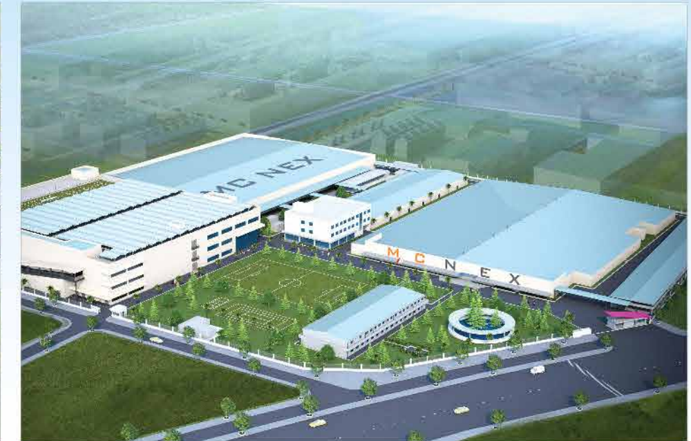
NHÀ MÁY MCNEX VINA KCN Phúc Sơn, P. Ninh Sơn, Tp. Ninh Bình, tỉnh Ninh Bình
