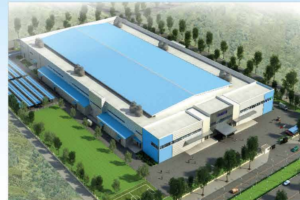
NHÀ MÁY DREAM TECH VSIP Bắc Ninh, Từ Sơn, Bắc Ninh
