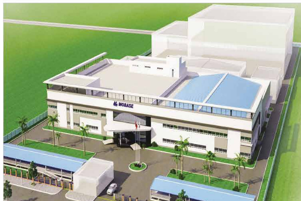
NHÀ MÁY MOBASE Long Châu, Yên Phong, Bắc Ninh
